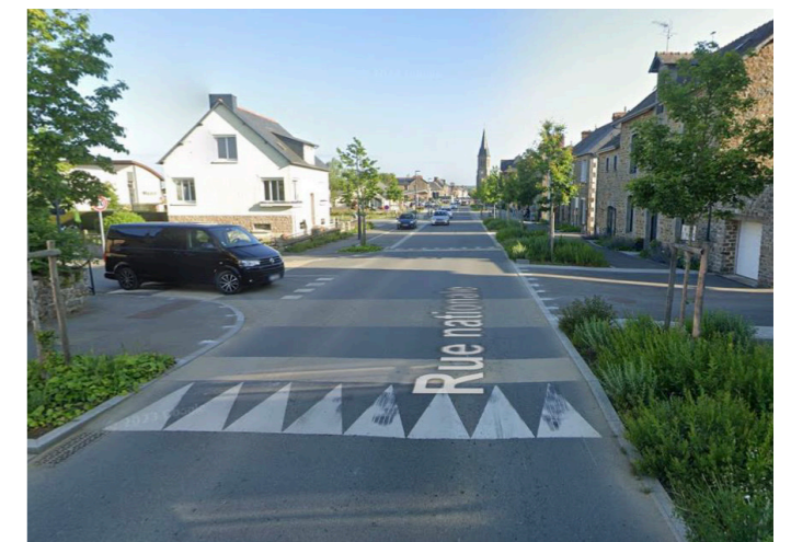
Végétalisation des abords de la chaussée pour structurer le stationnement
