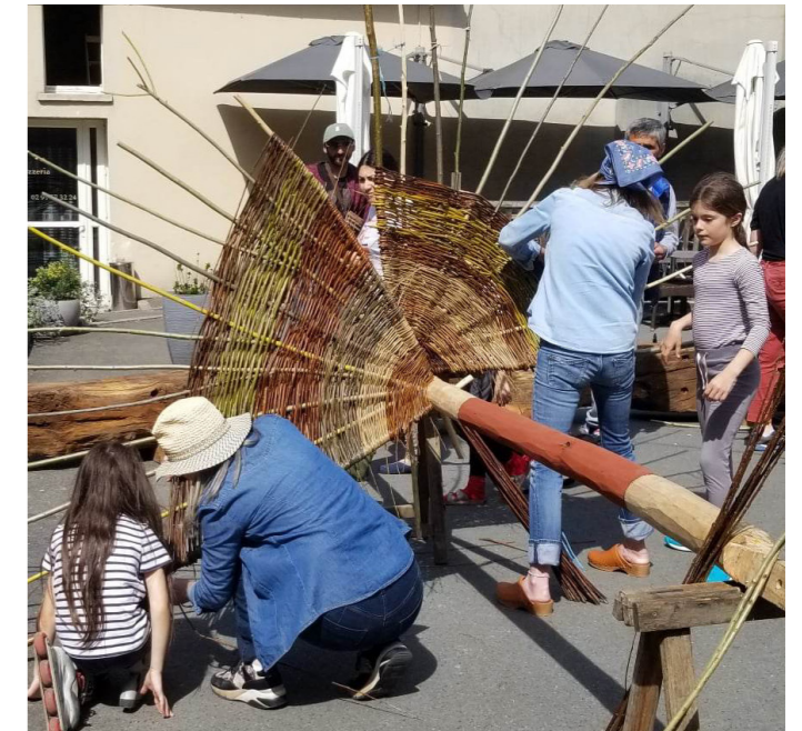
Du chantier au concert d'inauguration de la place
