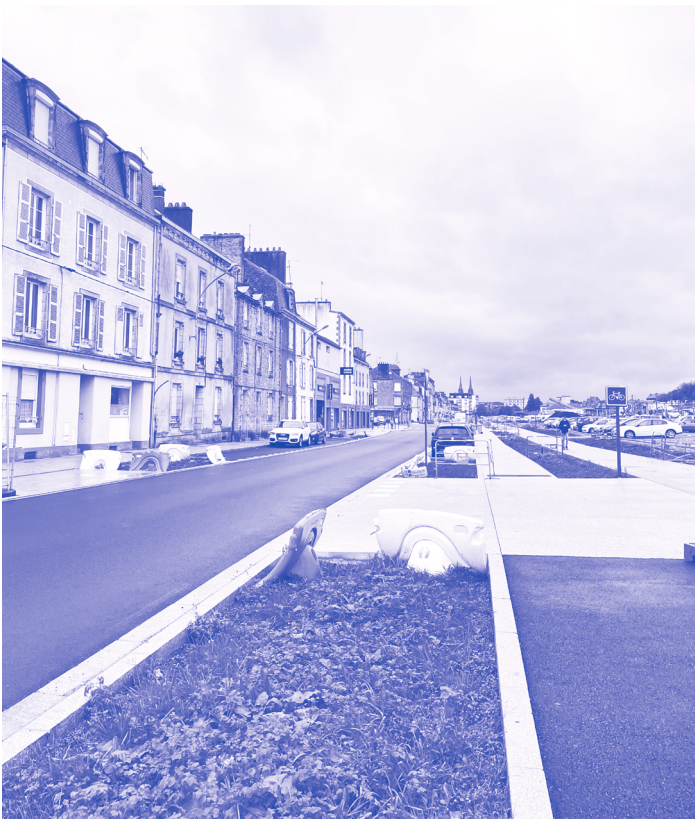
Livraison du parking longue durée avenue de la Libération. En second plan de la photo de gauche : la grande grue qui a permis de poser la passerelle la nuit du samedi 12 novembre dernier.
