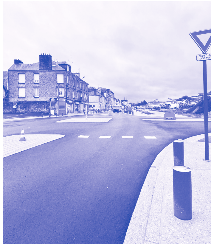
Une avenue de la Libération sur son 31 ! Bordures plantées, pistes cyclables, trottoirs élargis et chaussée neuve.
