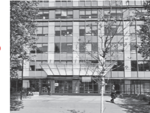
2 COUR INTÉRIEURE SNCF Marie 06 62 19 25 36
