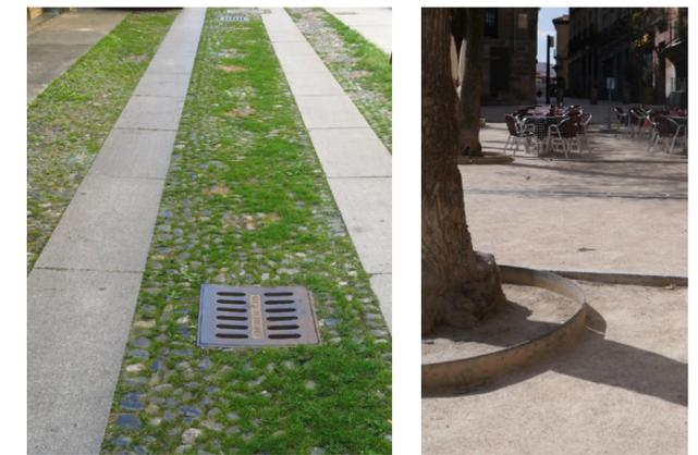
Revêtements perméables (pavés enherbés et stabilisés)
